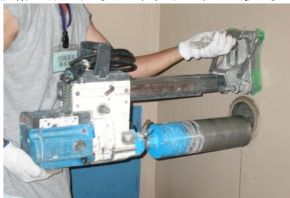
コンクリート試験体の採取
